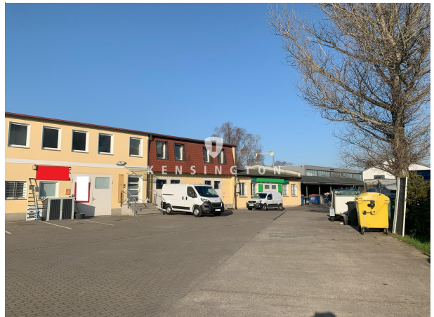
Eingang B + angrenzender Altbau
